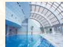
屋内温水プール
